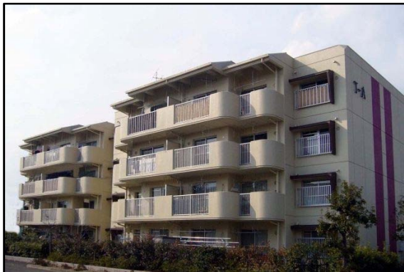
港北南荘（平成2年度建設）
